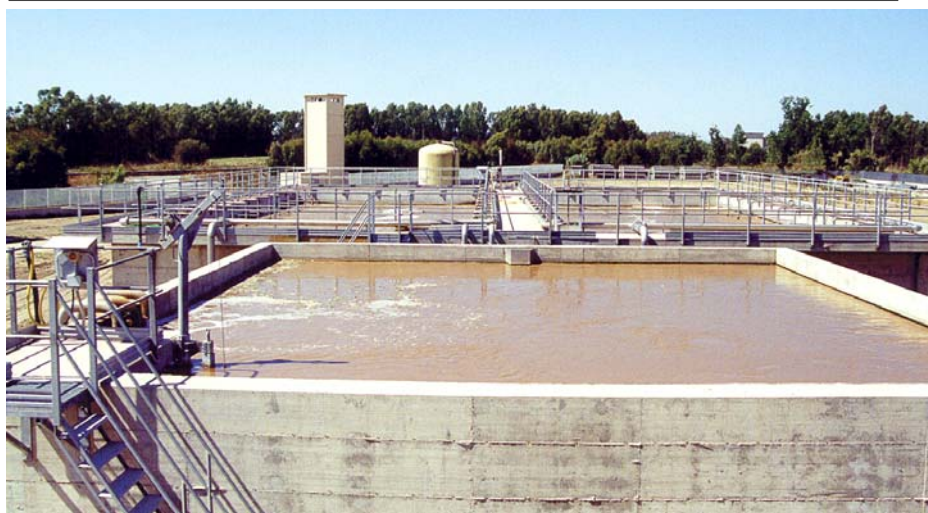
LA SEZIONE DI TRATTAMENTO CHIMICO-FISICO (FOTO IN ALTO) E LA SEZIONE DI TRATTAMENTO BIOLOGICO DELL'IMPIANTO 3A DI ARBOREA.
